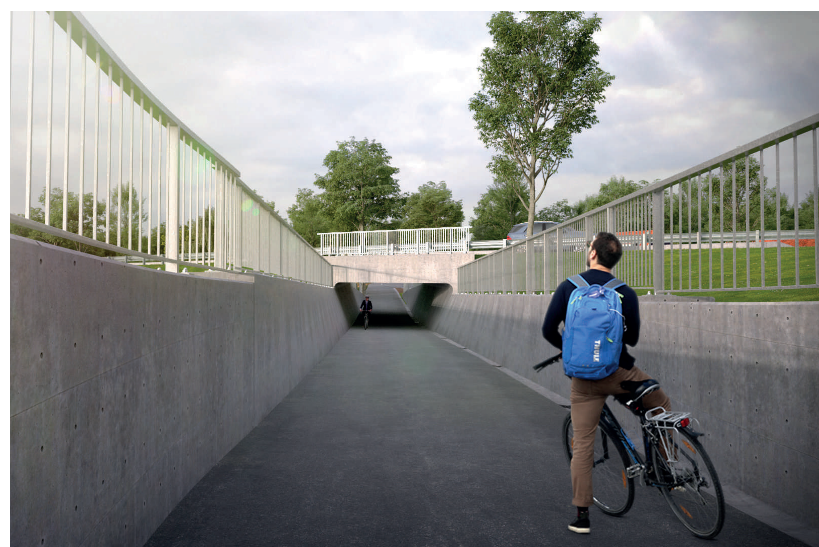
Fietstunnel Witte Brug
