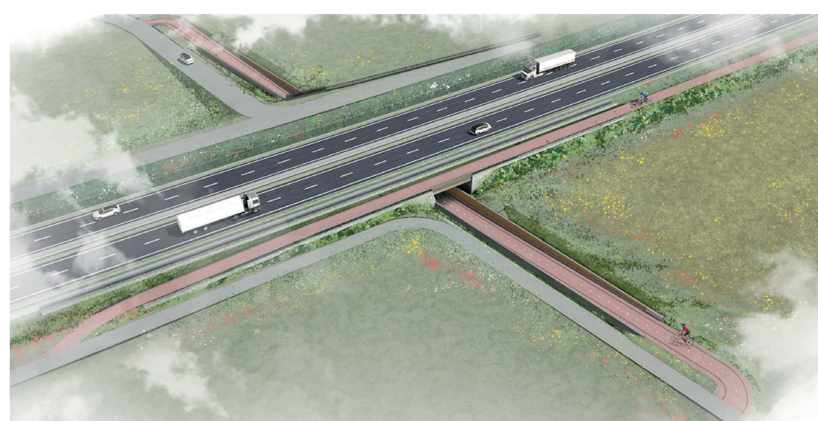
Ondergrondse tunnel voor fietsers en fauna
